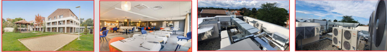
Résidence hôtelière Eklo 4**** + logements (Climax Elec)
